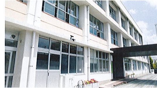
⑫中学校舎 中学専用の校舎で、普通教室以外に職員室、保健室、会議室、事務室があります。
